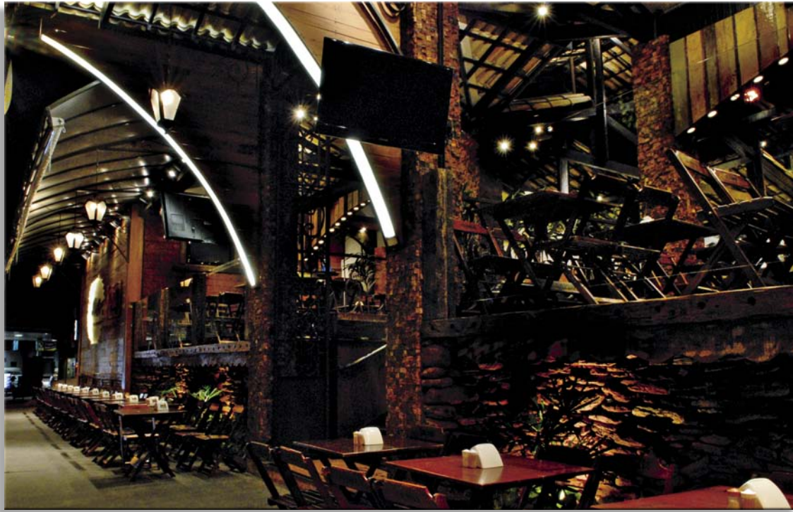
Iluminação da área externa, onde ficam as mesas, feita por grandes lanternas pendentes com lâmpadas incandescentes de 100W, com voltagem de 220V, ligadas a 127V. Spots com lâmpadas PAR 30 de 75W instalados a quatro metros de altura completam a solução.
